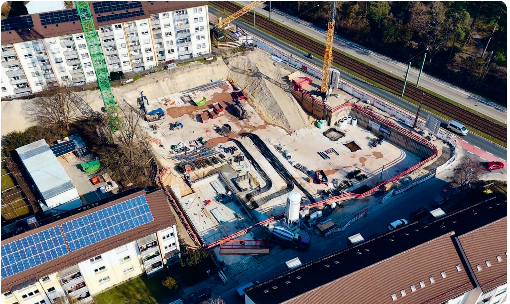
Die Baustelle an der Julius-Loßmann-Straße. Hier entstehen 80 neue Genossenschaftswohnungen und ein Nahversorger.
