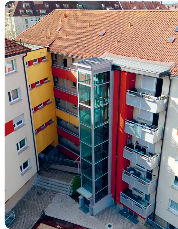
Aufzuganbau in der Ajtoschstraße.
