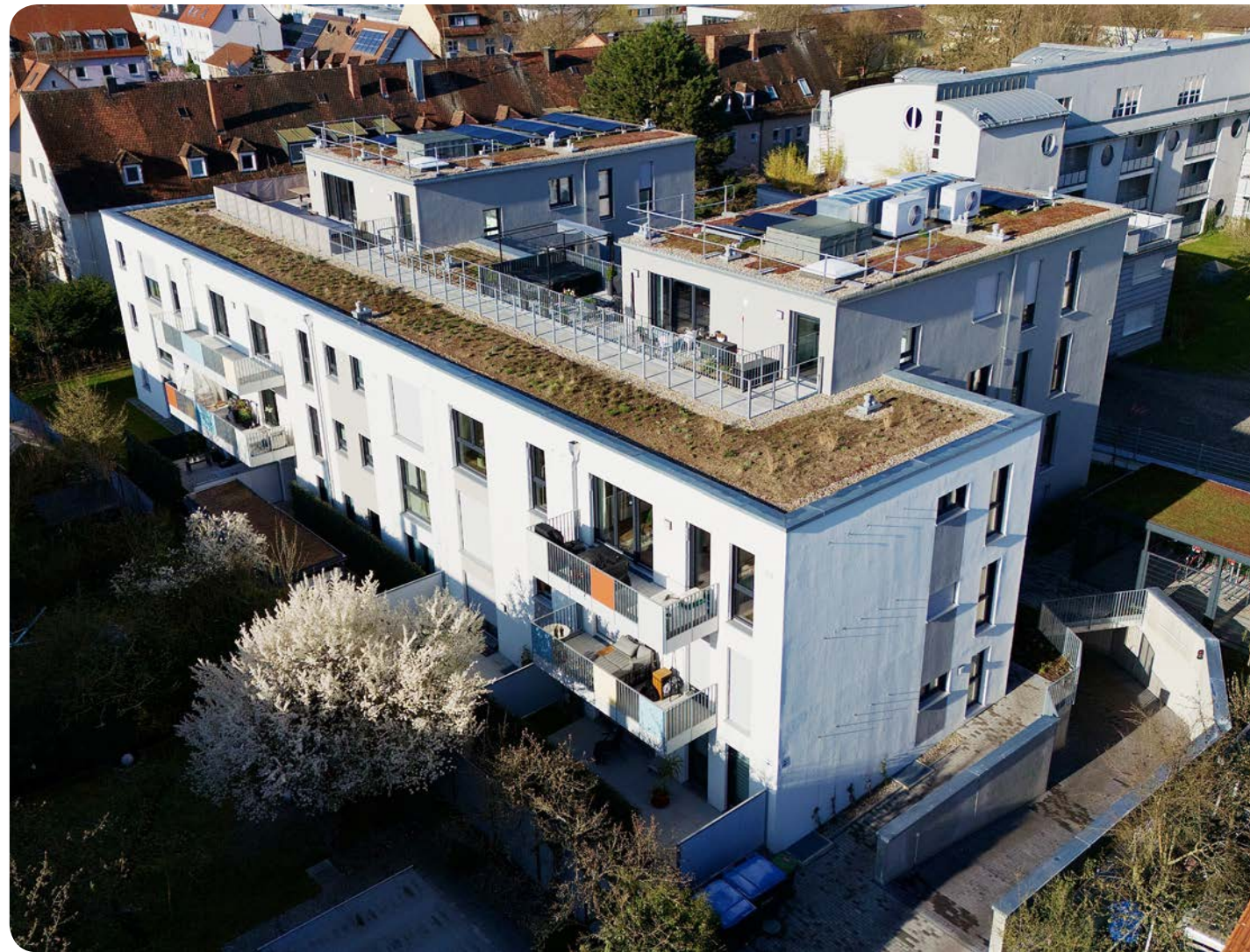
In der Nähe des ehemaligen Quelle-Areals entstanden 23 neue Wohnungen.
