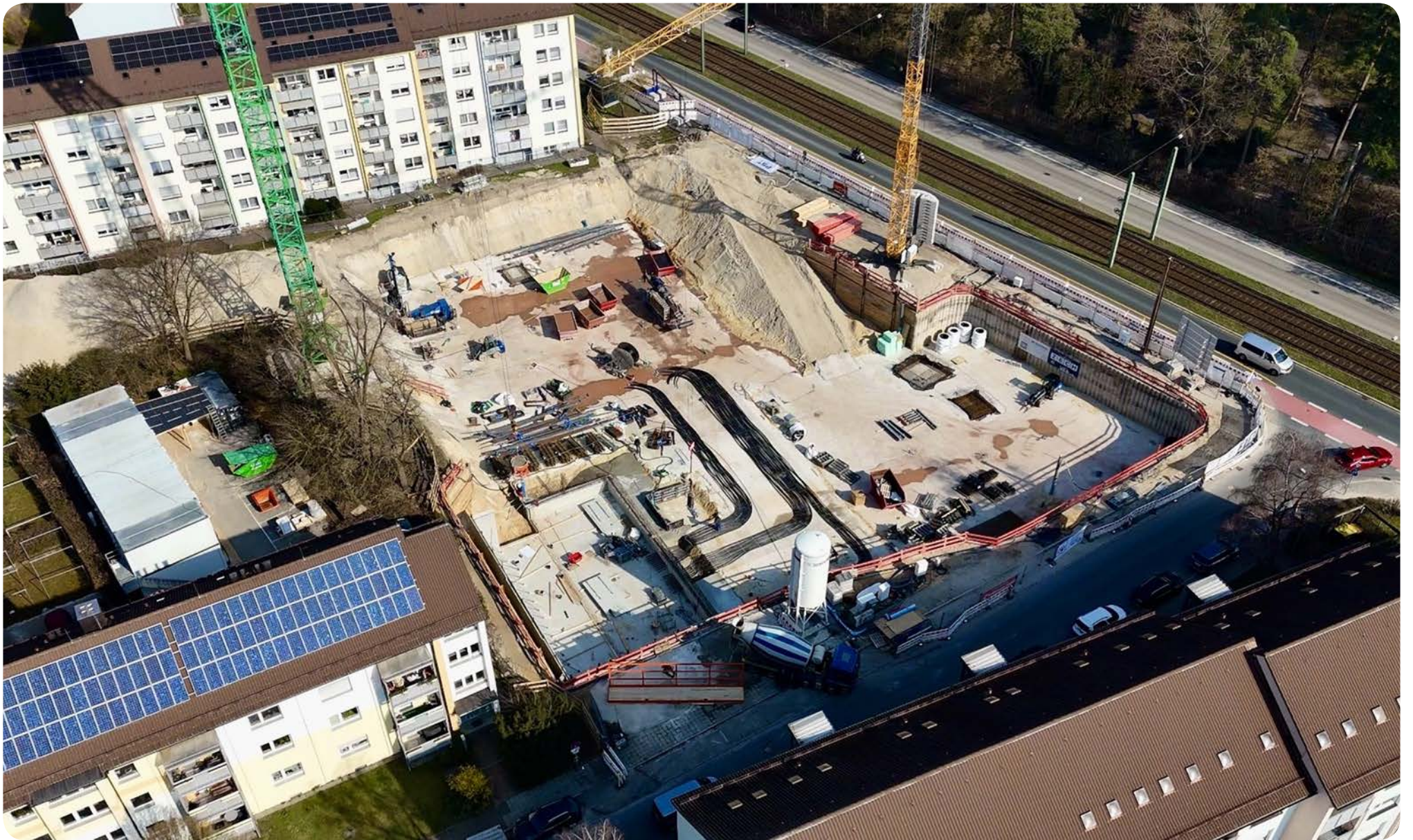
Die Baustelle an der Julius-Lobmann-Straße. Hier entstehen 80 neue Genossenschaftswohnungen und ein Nahversorger.
