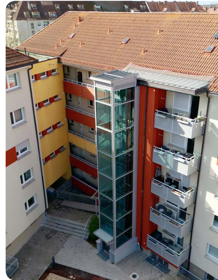
Aufzugsanbau in der Ajtoschstraße.
